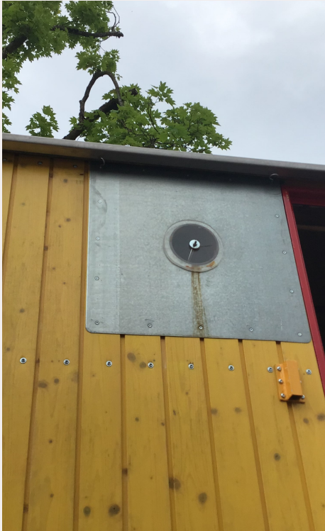
ANSCHLUSS FÜR HEIZUNGSRÖHR
